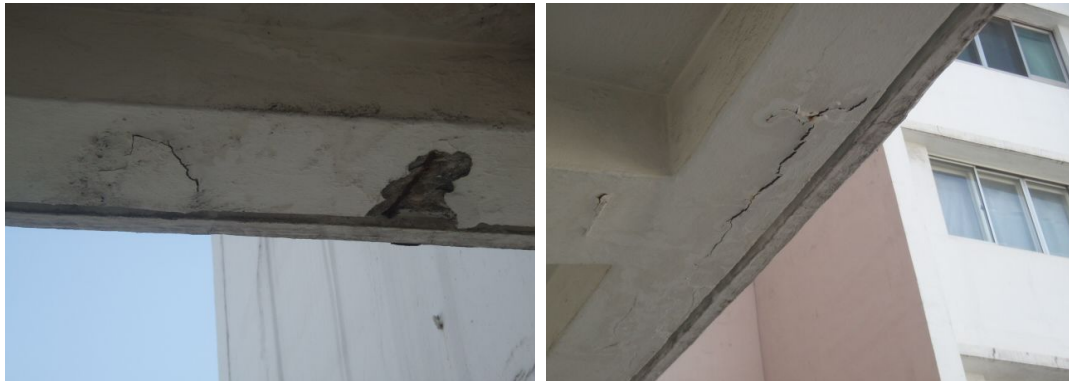
철근부식 의한 콘크리트 박락
